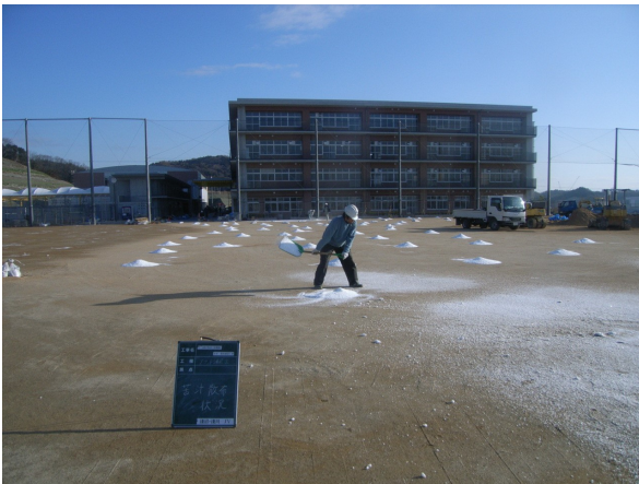
ソイルバインダー散布状況
