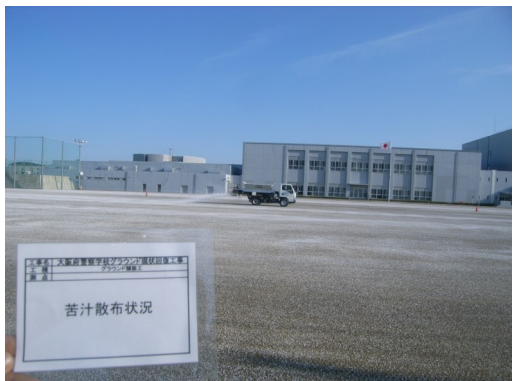
ソイルバインダー散布状況
