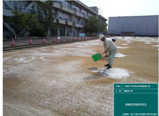
ソイルバインダー散布状況
